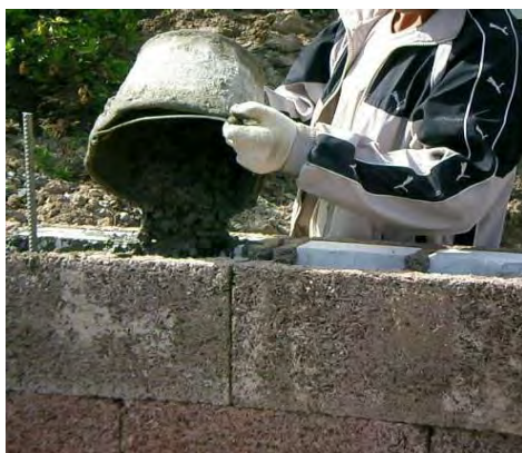
Подача раствора через бетонный бункер (колокол)
