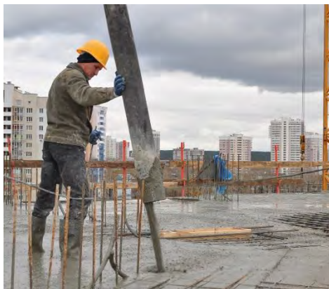
Подача раствора через бетонный бункер (колокол)
